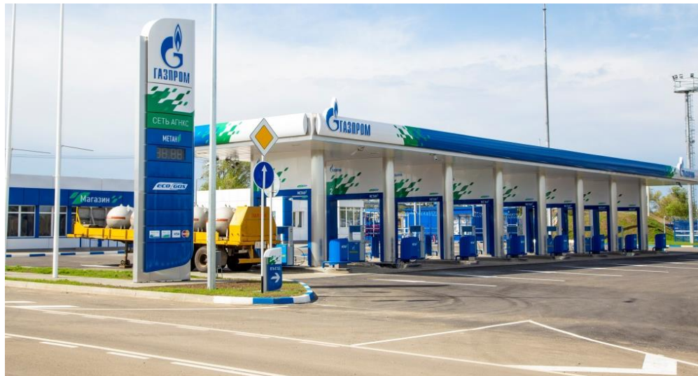
АГНКС-1, г. Новоалександровск, Ставропольский край
